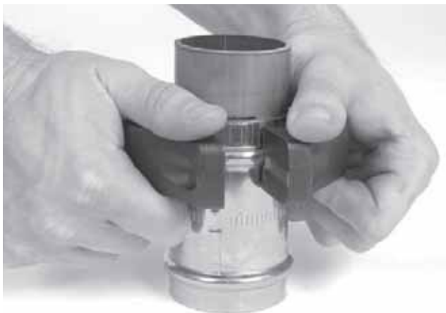
Figura 8 – Montaje del aro sellador en el acoplamiento
