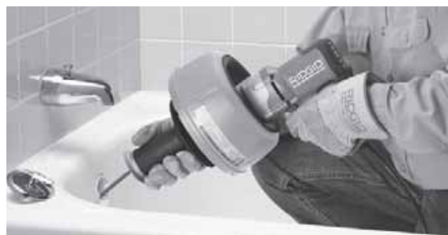
Figure 9 – Pousser le câble dans la conduite
